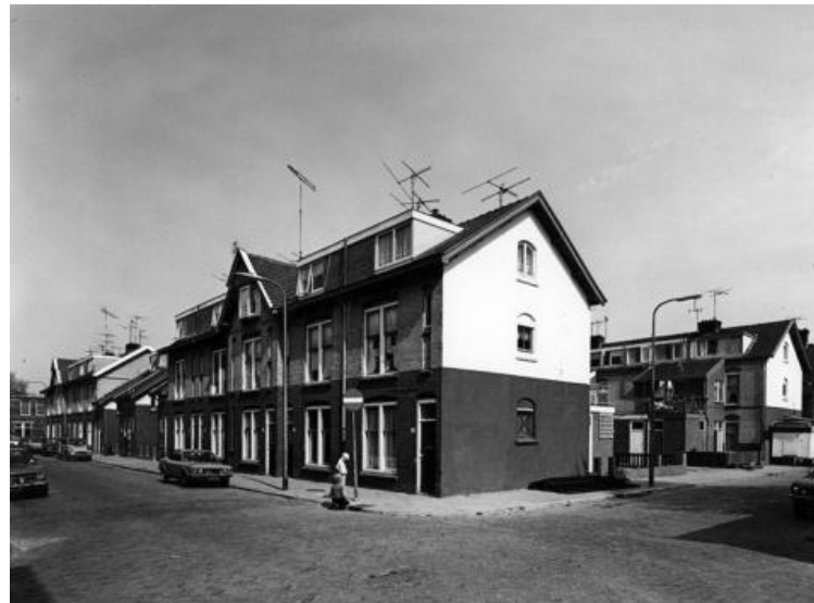
Eerste sociale woningbouw in Utrecht, Paramaribostraat, complex 501, opgeleverd in 1909, opdrachtgever NV Maatschappij tot Verbetering der Volkshuisvesting 'Jaffa'
